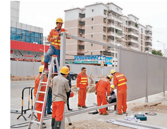
10號線平湖中心站開工，將成為“亞洲最長地鐵站”。
