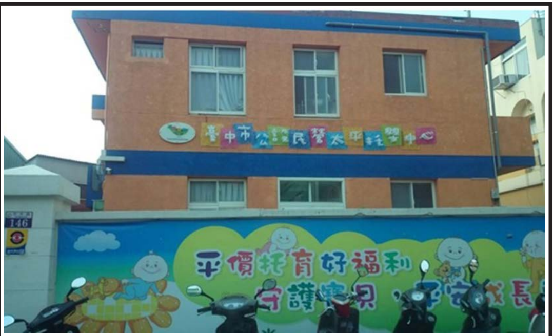
消滅蚊子館 中市活化閒置公設 為消滅蚊子館問題，台中市政府近來媒合多個機關進駐使用閒置公設，活化成為社會福利設施。原台中縣衛生局及太平區公所屬衛生所廳舍及儲藏空間，經社會局重新規劃，變成新新托嬰中心。（台中市政府提供）
