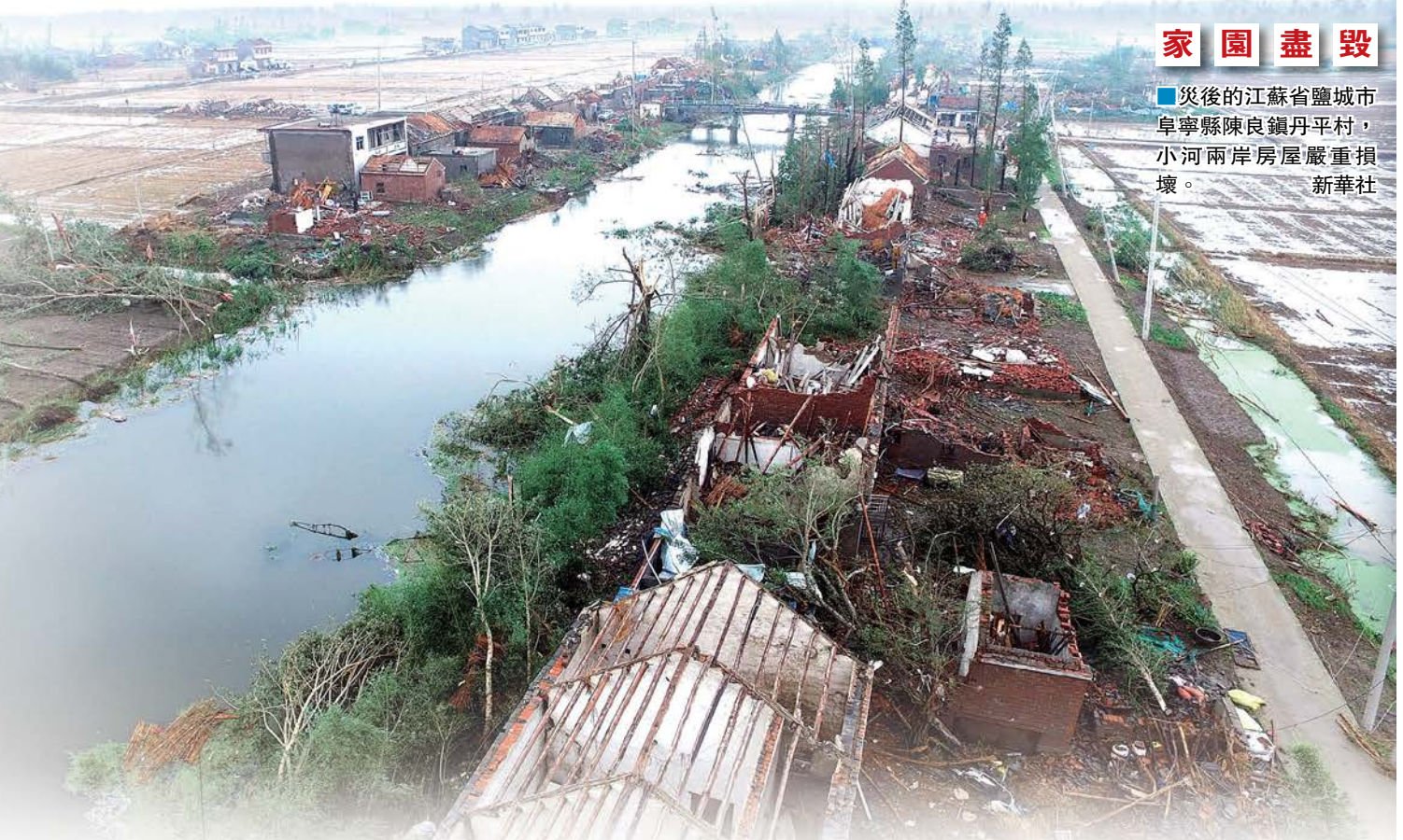
家園盡毀 災後的江蘇省鹽城市阜寧縣陳良鎮丹平村，小河南岸房屋嚴重損壞。新華社
