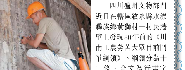
當地文物保護人員正在維修鋼網。 本報四川傳真
