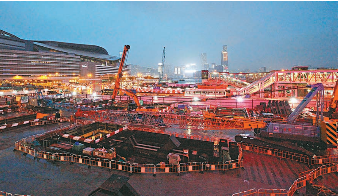
港鐵10日傍晚宣佈，暫停會展站所有相關挖掘工程。
